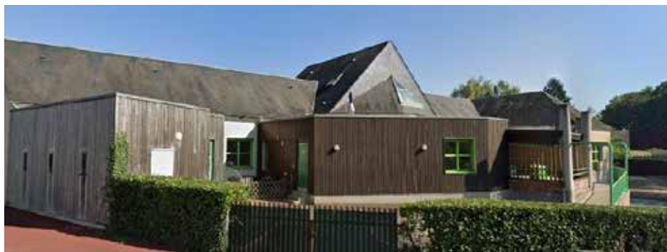
Entrée par la Rue de Pruillé - AVANT
