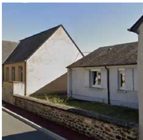
Rue de Pruillé, face à la Rue des Tilleuls - AVANT
