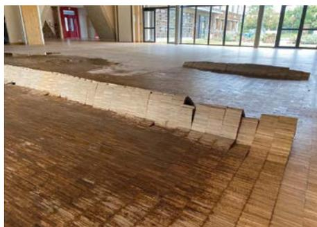
Après quelques recherches, la fuite sur le toit a pu être localisée. Les chêneaux de toiture se sont trouvés saturés sans pouvoir évacuer le surplus d'eau qui a trouvé un autre chemin, vers l'intérieur de la salle.
